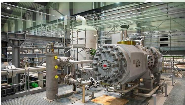
*Гигантские тепломоносы обеспечат централизованное теплоснабжение с нулевым уровнем выбросов для всего города Эсбьерг (фото: MAN)*
