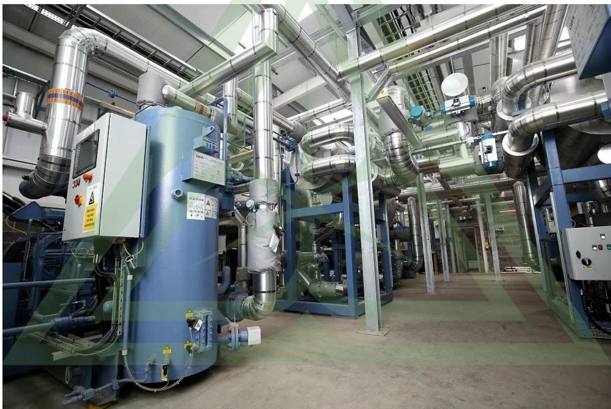
Мощные тепловые насосы для централизованного теплоснабжения с использованием шахтной воды в Гейтсхеде (фото: GEA).
