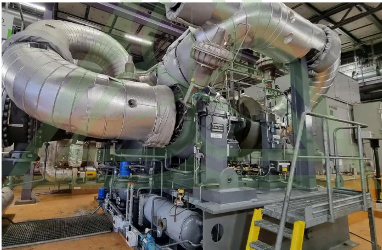
Турбокомпрессор промышленного теплового насоса в Стокгольме. Источник: Atlas Copco Energas GmbH.
